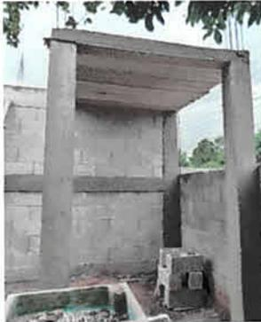
Foto 3: Terraza para la colocación del tanque de agua finalizada
